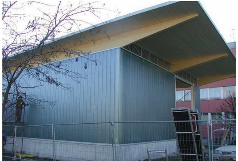
Modernisierung und Erweiterung als Investition in die Zukunft (im Bild die neue HFA-Lagerhalle während der Bauphase)
