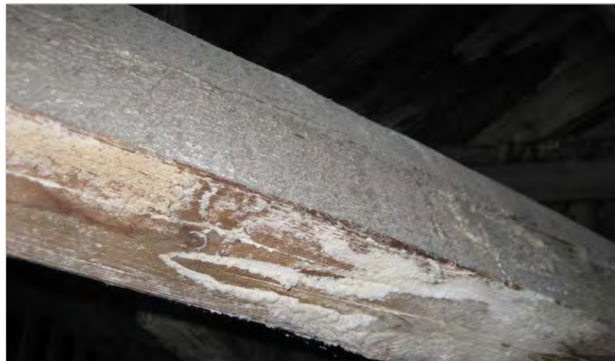
Historische Anpassung an den Stand der Technik als Herausforderung im heutigen Re-Use: Im Zweiten Weltkrieg aus Brandschutzgründen gekalkter Dachstuhl
