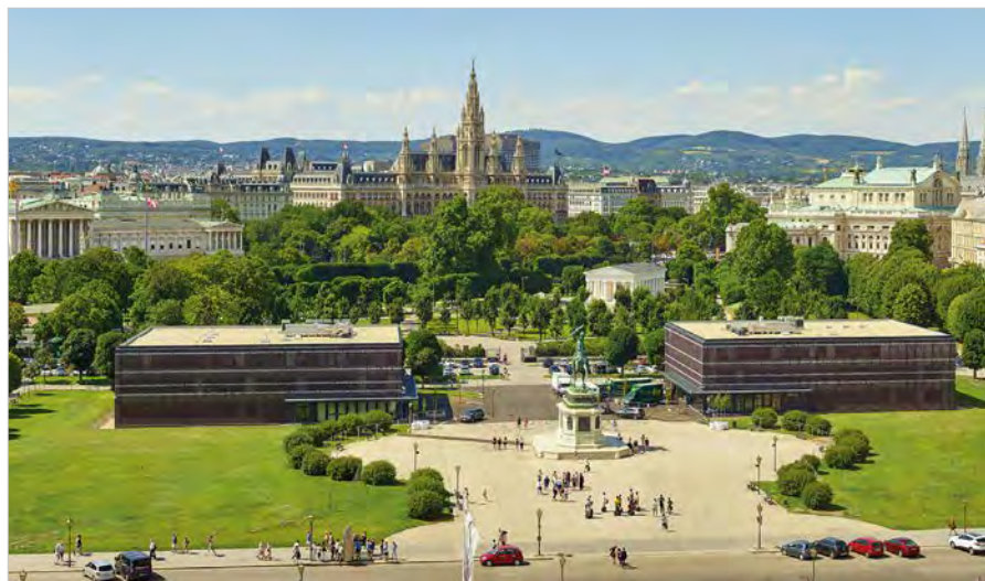
Das Ausweichquartier für das österreichische Parlament wurde im Herzen von Wien von der Firma Lukas Lang Building Technologies als Holzbau für den Re-Use konzipiert und bereits wieder abgebaut.
