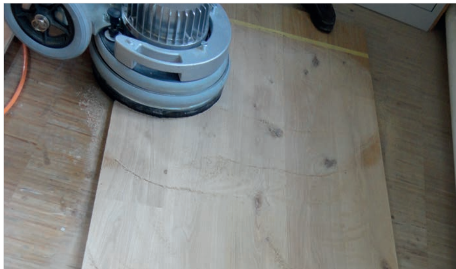
Bei der Renovierung von strukturierten Fußböden ist auf die richtige Schleifmittelauswahl zu achten.
