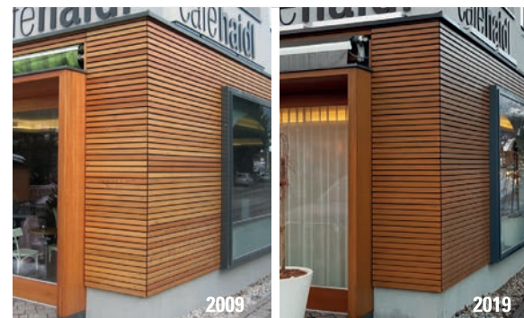
Farbveränderung an einer Fassade durch natürliche Bewitterung und Wartung.
