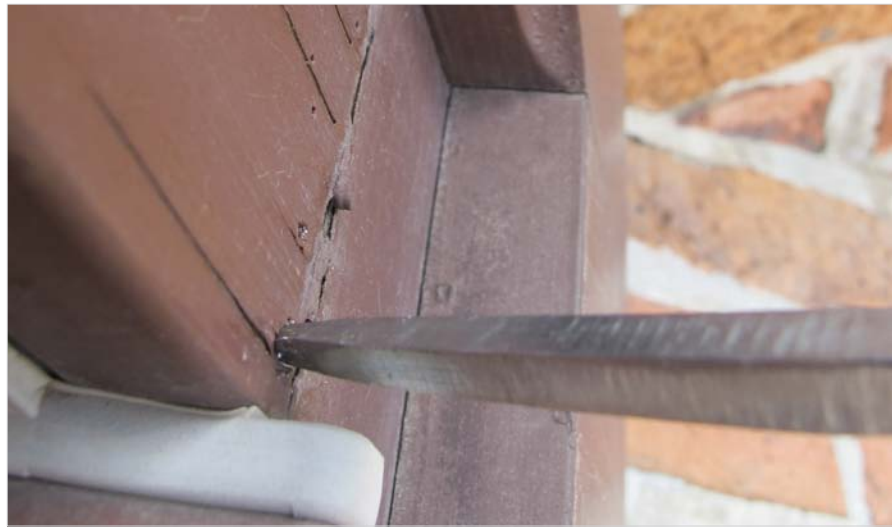
Bei der Bewertung von Altfenstern werden einfache Hilfsmittel wie Spitzbohrer und Maßband zu Hilfe genommen.
