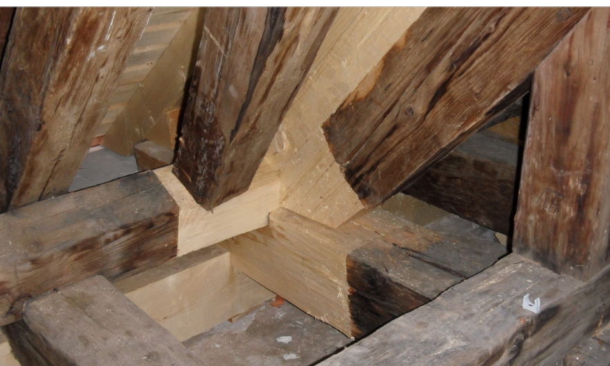
Sanierter Dachstuhlkonstruktion in der Kollegienkirche in Salzburg
