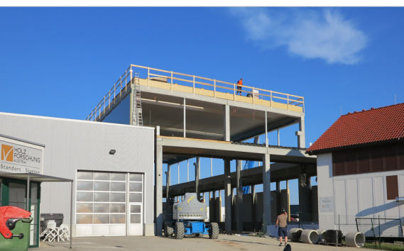
Durch den schnellen Baufortschritt kann das Schalllabor schon im Oktober eröffnet werden
