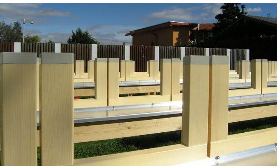
Exponierte Fensterecken am Freigelände der Holzforschung Austria
