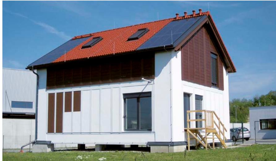
Im Zuge des Teilprojektes „Energy Efficiency“ entstand am HFA-Standort in Stetten das 1:1 Forschungshaus
