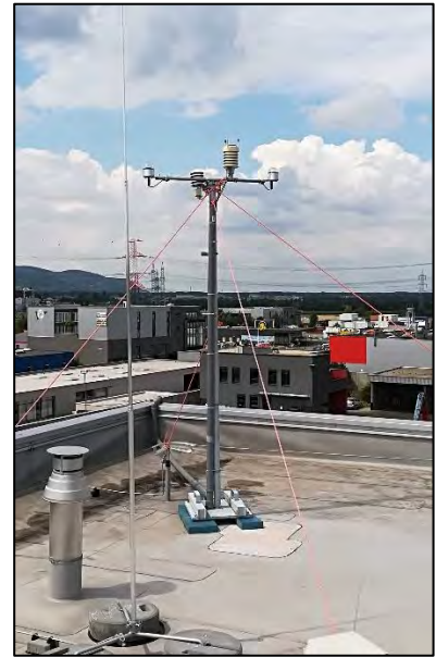
Abbildung 14: Wetterstation am Dach des ACA in Stetten
