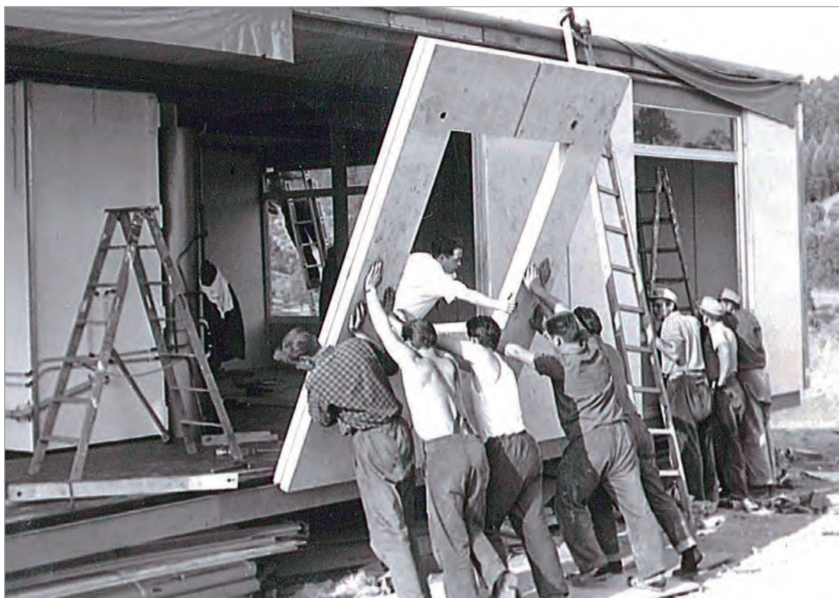
Für die Montage eines Fertighauses benötigte es in den 1960er Jahren noch viel Muskelkraft
