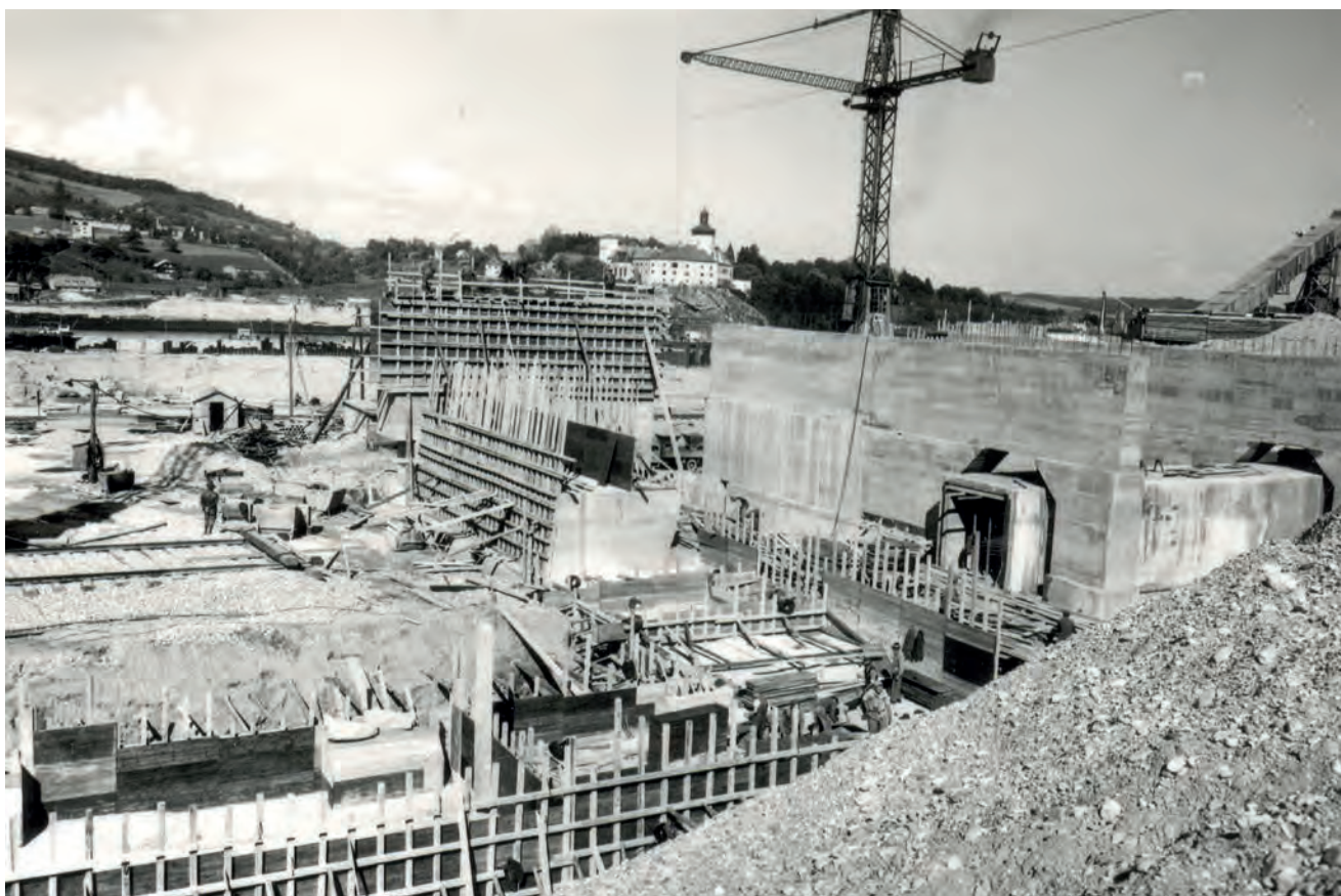
Erstmalige Verwendung von Schalungsplatten (DOKA) beim Bau des Donaukraftwerks Ybbs-Persenbeug
