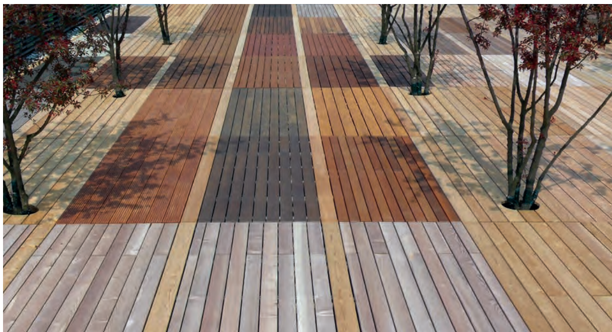
Auf der Gartenausstellung in Tulln wurde für Forschungszwecke eine Versuchsterrasse errichtet
