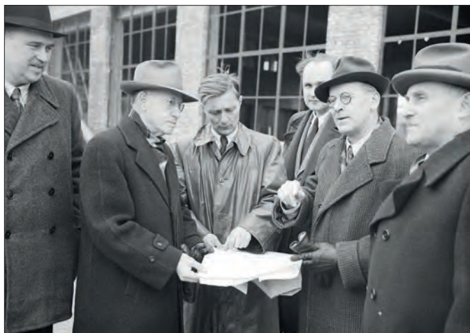
Baustellenbesprechung im Arsenal: (v.l.n.r.) Alfred Gratzl, George M. Hunt, Wilhem Serentschy, Herbert Neußer, Josef Kisser und Heinrich Wartburg
